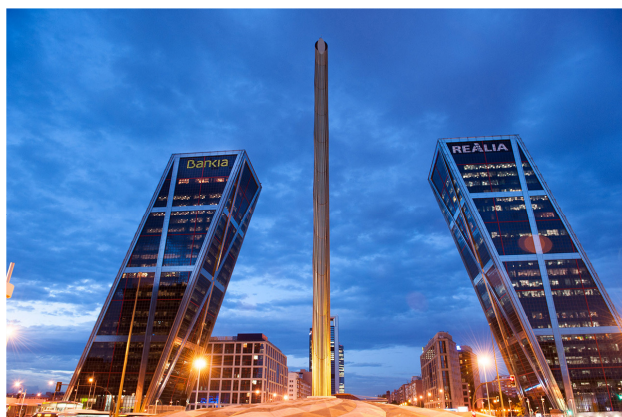
Puerta de Europa Torres KIO, 114m, 1996 (Phillip Johnson & John Burgee)
